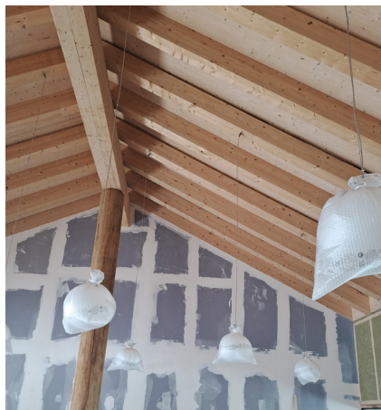
Pose des lustres (encore protégés)
