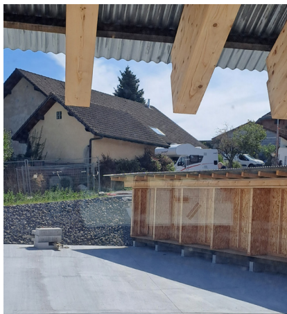
Meuble de rangement extérieur en attente de porte
